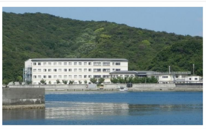
全面改築後の病院(現在)
